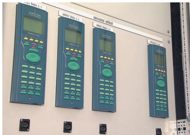
Prepočítavače prietoku vypočítavajú v rámci meracej stanice množstvo pretečeného plynu a jeho spälné teplo.
