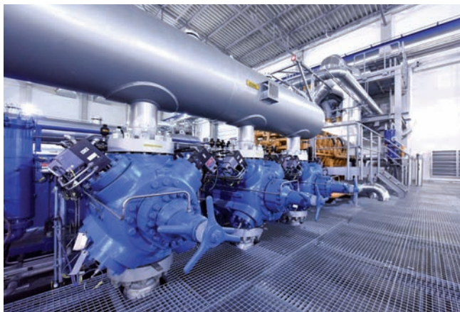
Tri piestové kompresorové agregáty určené na zatlačanie plynu do podzemných horninových štruktúr
