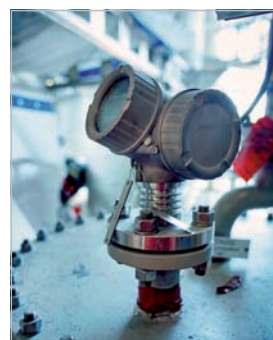
Levelflex FMP5x v sekcii úpravy vody
