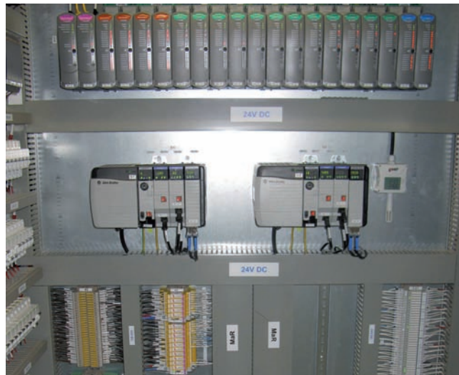
Riadiaci systém Allen-Bradley ControlLogix na riadenie jednotlivých sond
